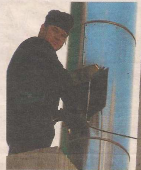
Am Dach säubert Stefan Harrich den Rauchfang mit einer Bürste
